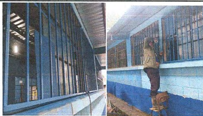
Foto 4: Mantenimiento de balcones
