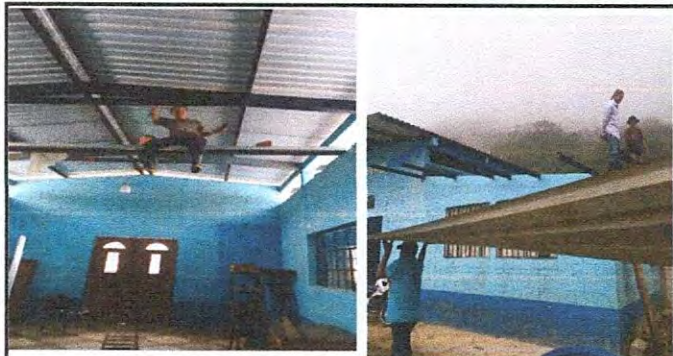
Foto1: Sustitucion de techo del establecimiento y mantenimiento de la estructura de soporte de metal.
