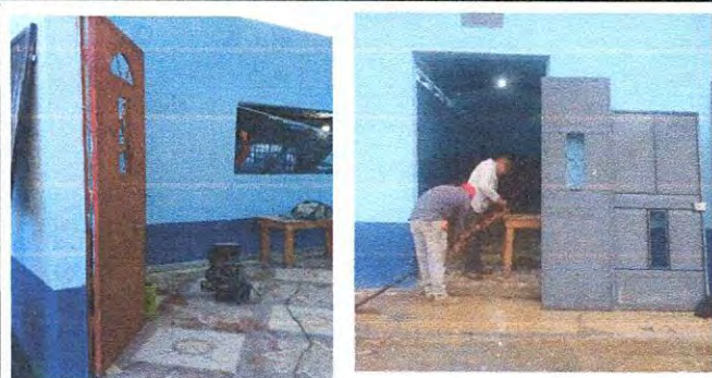
Foto 3: Sustitucion de porton de metal
